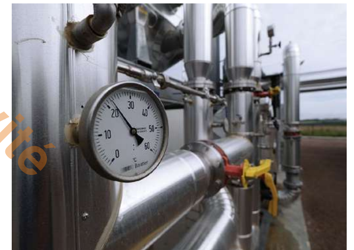
→ Centrale hydroélectrique de Chizonnet (Loire)
