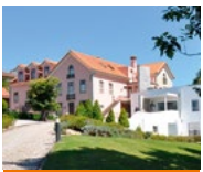
EHPAD Ribeira de Fraguas (Portugal)
